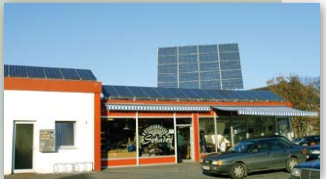
Geschäftshaus in Erwitte 30,0 kWp
