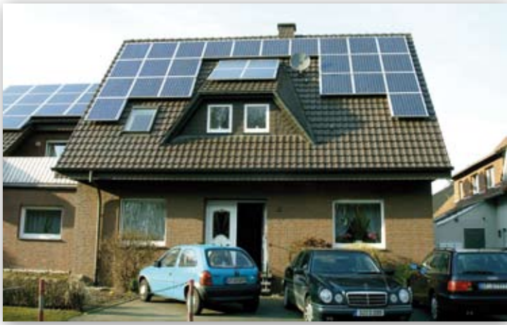
1-Fam.-Haus in Rheda-Wiedenbrück 9,24 kWp
