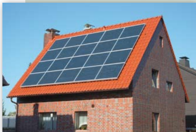
5,5 kWp PV Anlage auf einem Einfamilienhaus
