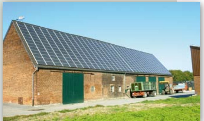
Landwirtschaftliches Gebäude in Bad Westernkotten 42,0 kWp
