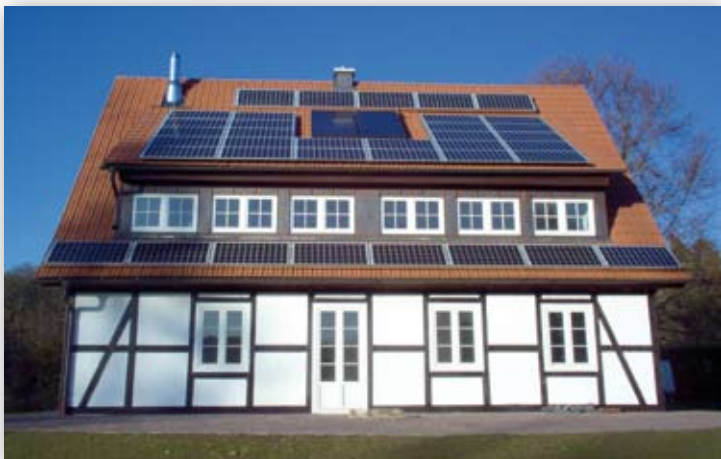
Fachwerkhaus in Eichenhagen 6,29 kWp
